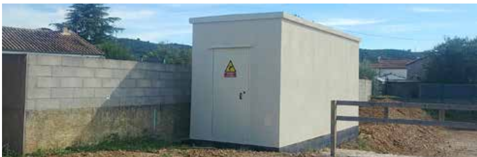
• Bâtiment N.R.O. (Nœud de Raccordement Optique)
