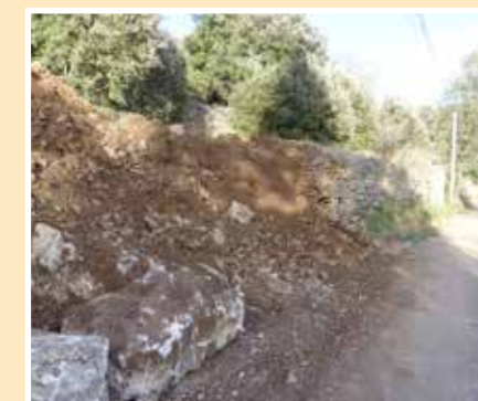
ENROCHEMENT CHEMIN D'ARBUSSE
