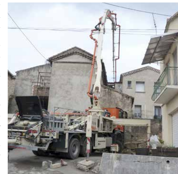
OPÉRATION DE POMPAGE BÉTON
