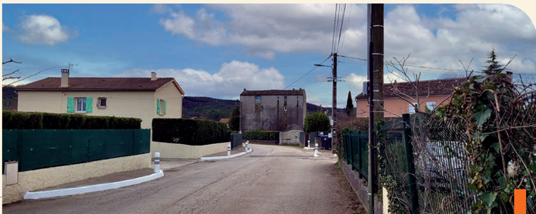
Chemin du grès : sécurisation
