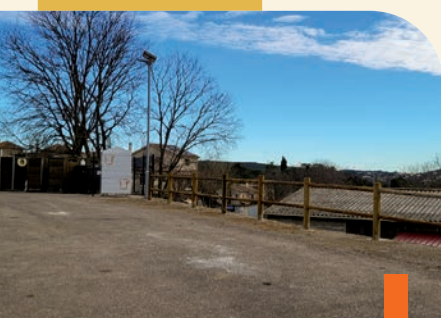
aménagement éclairage public
