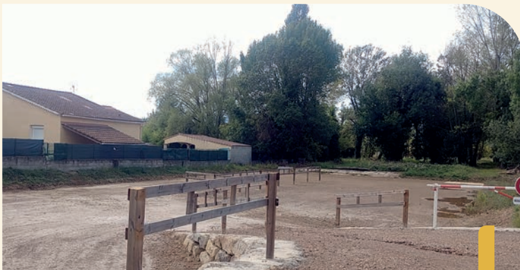
Parking cuvette de rétention MANDELA
